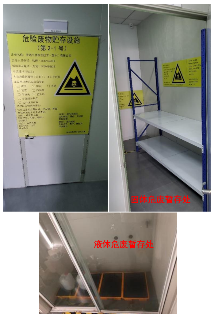
图 7-2 危险废物仓库
