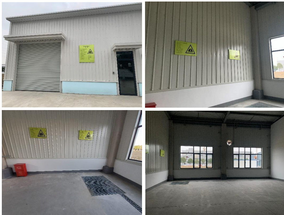
图 7-2 危废仓库现场照片
