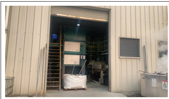
中水回用外部
