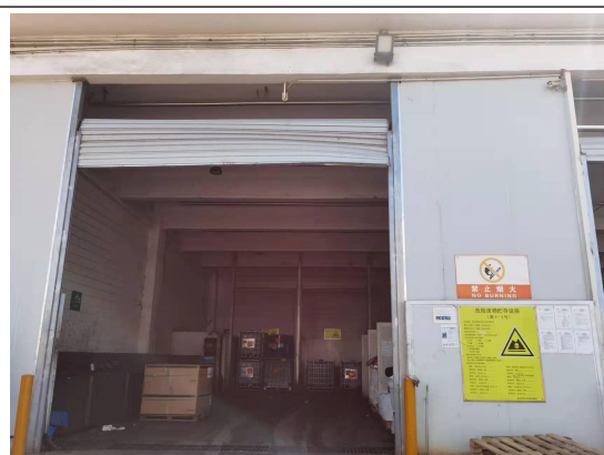
危废仓库内部
